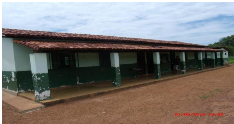
Figura 17 - Vista externa da Escola
