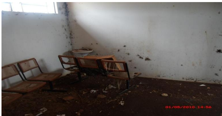
Figura 20 - Vista interna do posto médico – desativado
